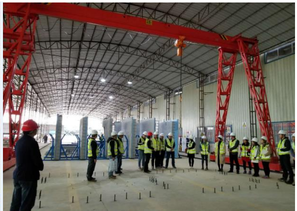
装配式建筑吊装实训现场
